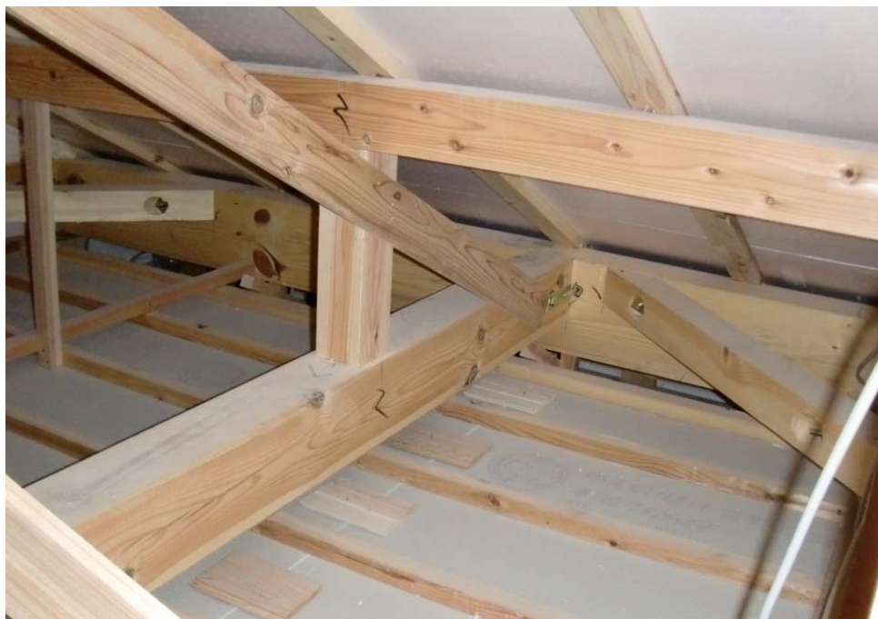
小屋裏の状況①（宮城県利府町 築2年、H24年2月撮影）
