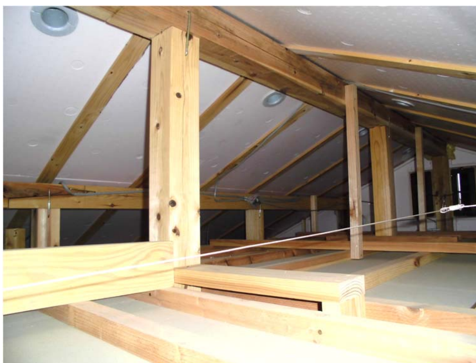
小屋裏の状況②（宮城県仙台市 築11年、H29年8月撮影）
